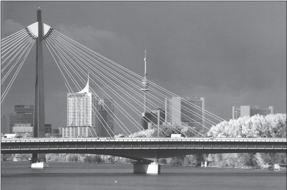
Bécs, új híd, új épületek a Duna-toronyral
